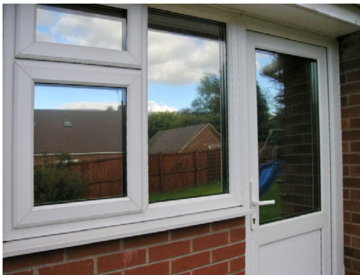
Reflexivní folie snižuje propustnost na cca 40 %.
