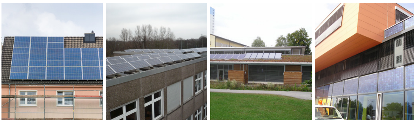
Na obrázcích jsou různé aplikace FV panelů (šikmá střecha rodinného domu, plochá střecha školy, kombinace s ozeleněnou střechou a vertikální panely)
